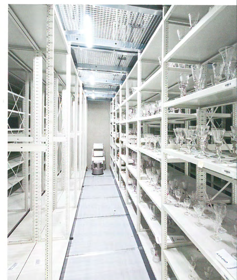
De opslagsystemen zijn dubbellaags, met roostervloeren ertussen voor de juiste luchtstromingen.
