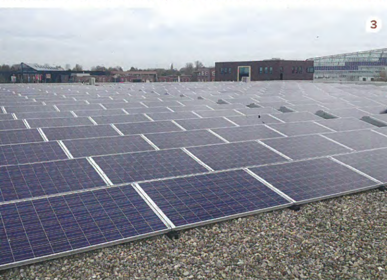
1 // De wanden zijn dubbellaags geïsoleerd, met verspringende naden. De naden tussen de prefab betondelen zijn zorgvuldig afgedicht. De balusters voor de dakopstand zijn bevestigd met koudebrugonderbreking. 2/3 // Voor de PV-systemen op het dak is gekozen voor geballaste systemen. Zo hoefde de dakbedekking niet te worden doorbroken. Om materialen te kunnen scheiden bij sloop is ook de dakbedekking geballast.
